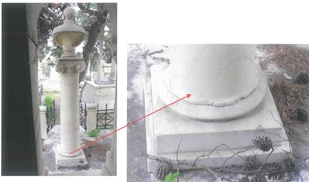
Εικόνα 15, 16: Θραύσεις και απώλεια υλικού στη βάση του κίονα της προτομής στο ταφικό μνημείο Νικηφόρου Γεωργιάδου.
