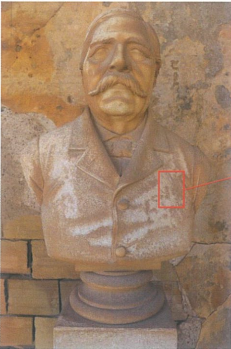
Εικόνα 10, 11: Ζαχαροποίηση σε μαρμάρινη προτομή στο ταφικό μνημείο Γεωργίου Γιαννίκογλου.
