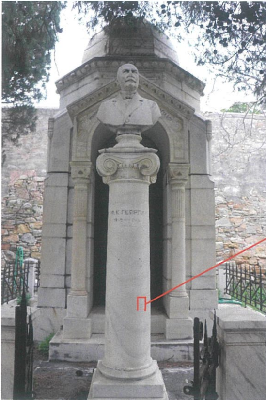
Εικόνα 8, 9: Ζαχαροποίηση στη μαρμάρινη στήλη που φέρει την προτομή του Νικηφόρου Γεωργιάδου.
