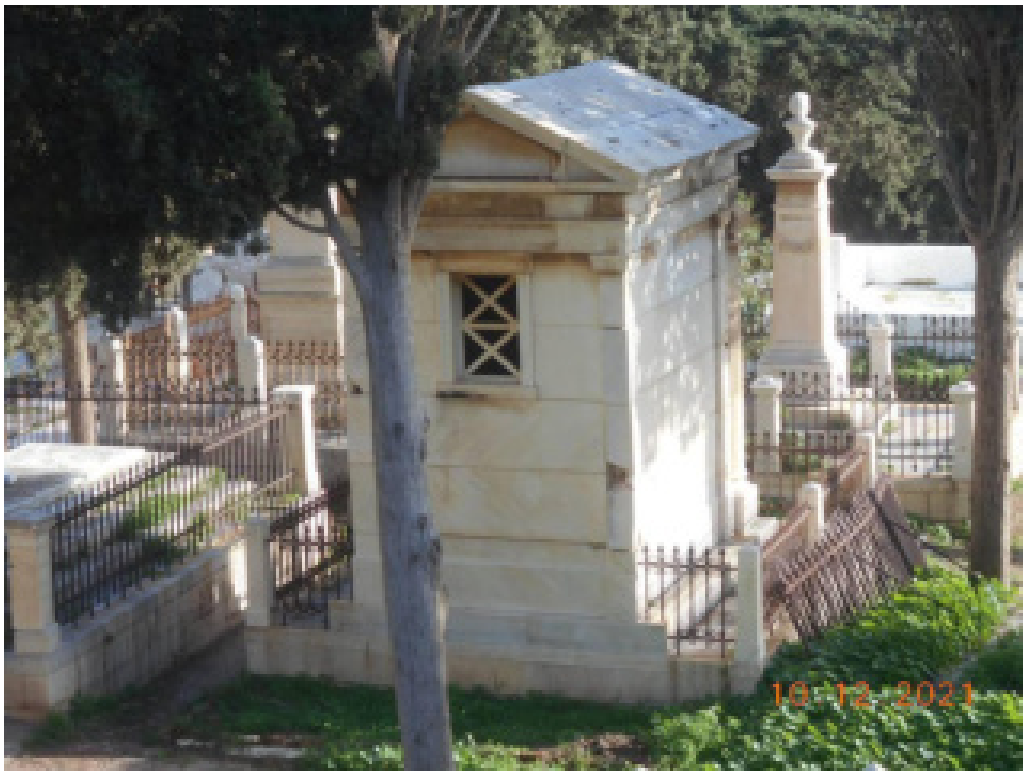
Φωτ. 11. Ανύψωση του τυμπάνου του αετώματος της δυτικής όψης.
