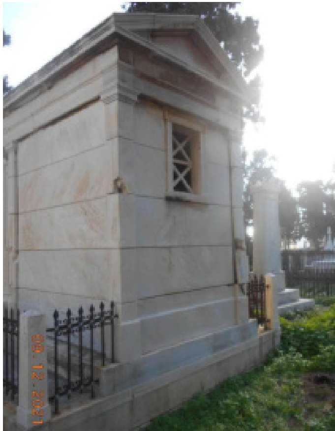
Φωτ. 3. Μνημείο Ν. Πρασσακάκη. Γενική άποψη του μνημείου (Βορειοδυτική πλευρά).
