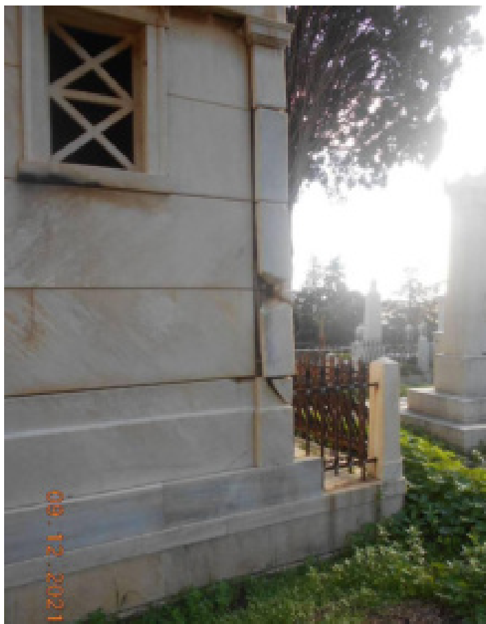
Φωτ. 4. Κατακερματισμένη παραστάδα στην νοτιοδυτική πλευρά του μνημείου
