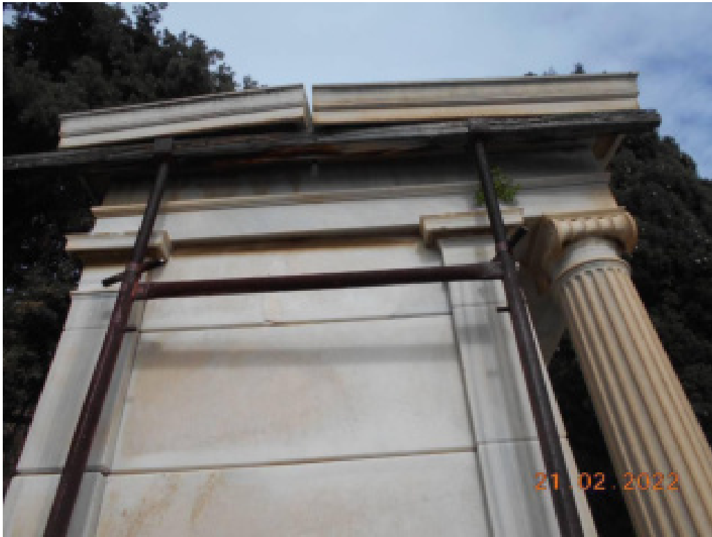
Φωτ. 33. Το ικρίωμα υποστήλωσης στην νότια πλευρά του μνημείου.
