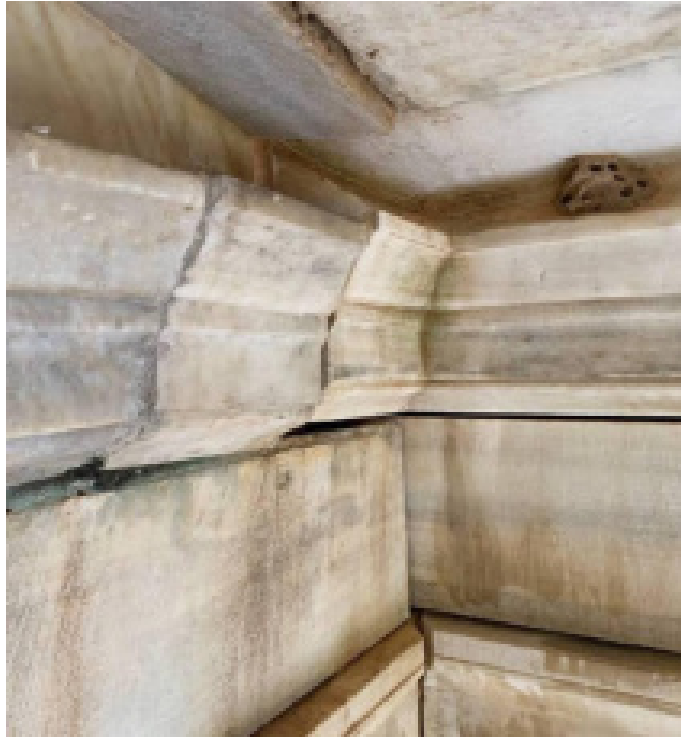
Φωτ. 19. Διάνοιξη οριζόντιου αρμού μεταξύ διαζώματος και γείσου στο εσωτερικό του μνημείου.
