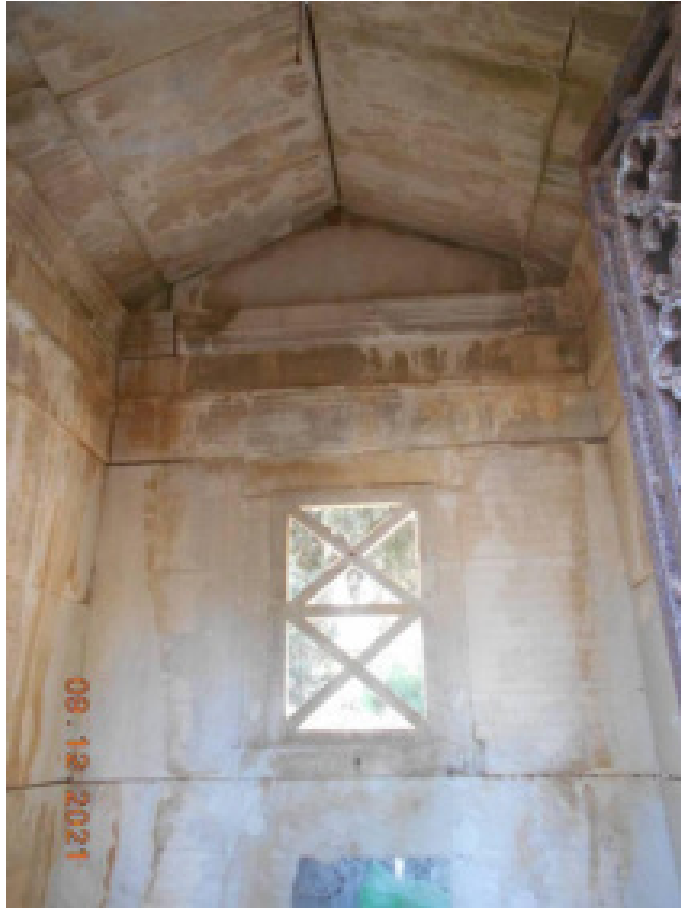
Φωτ. 10. Διάνοιξη των οριζόντιων αρμών των λιθοπλίνθων και των αρμών των λιθόπλακων της στέγης
