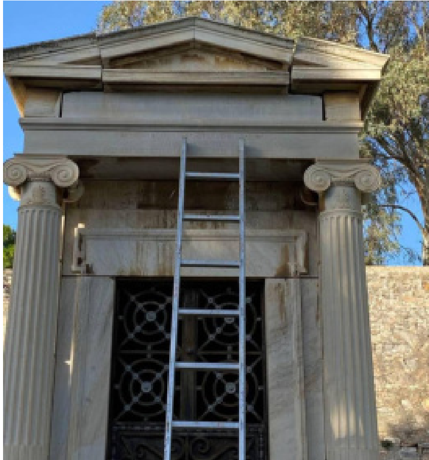
Φωτ. 15. Διανοίξεις αρμών από τη στάθμη του υπέρθυρου και άνω.
