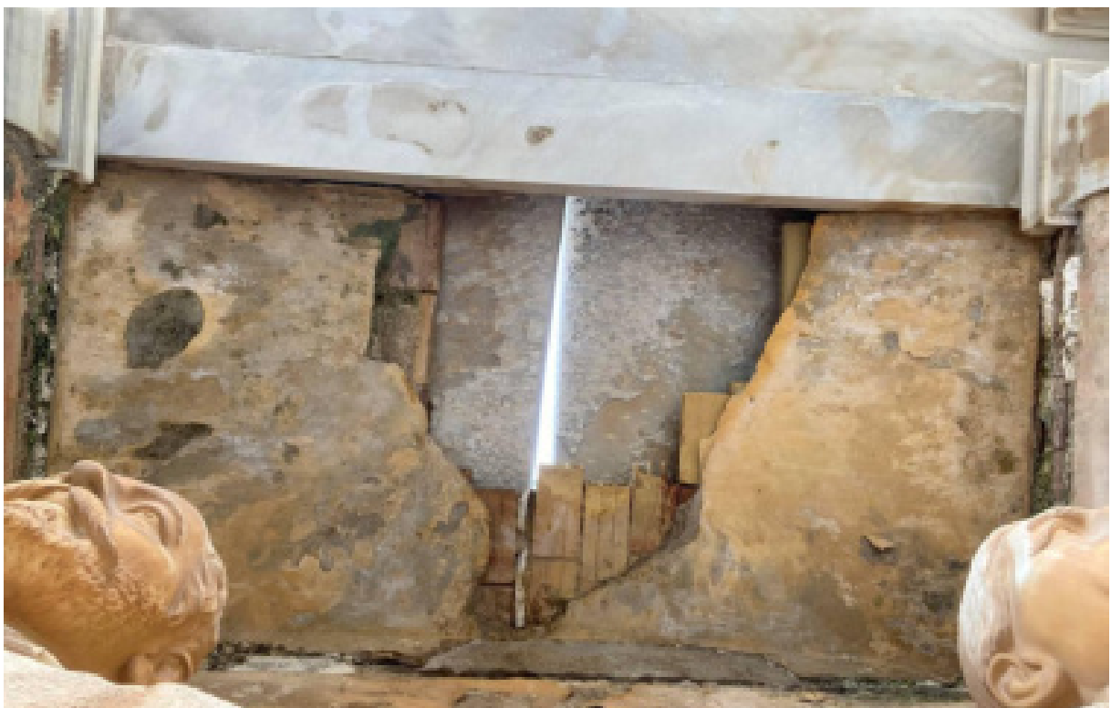
Φωτ. 31. Η αποδομημένη ανωδομή του μνημείου . Διακρίνονται οι λιθόπλακες της στέγης που είναι μετέωροι πάνω από τους αποσαθρωμένους θολίτες
