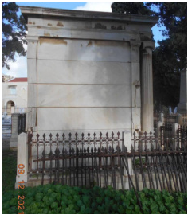
Φωτ. 5. Κατακερματισμένες παραστάδες στην δυτική πλευρά του μνημείου
