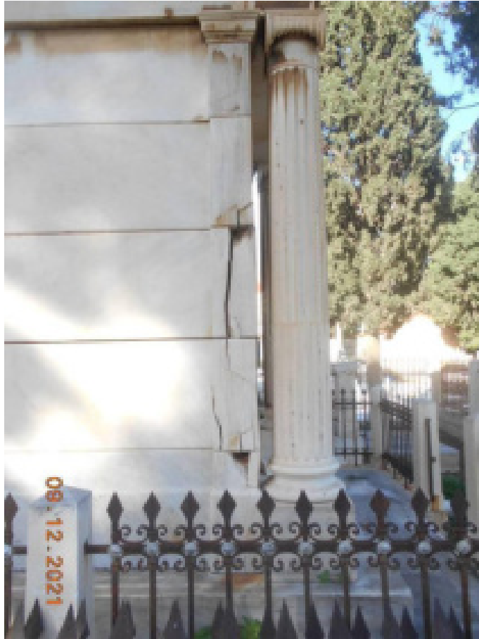
Φωτ. 8. Κατακερματισμένη παραστάδα στην νοτιοανατολική πλευρά του μνημείου
