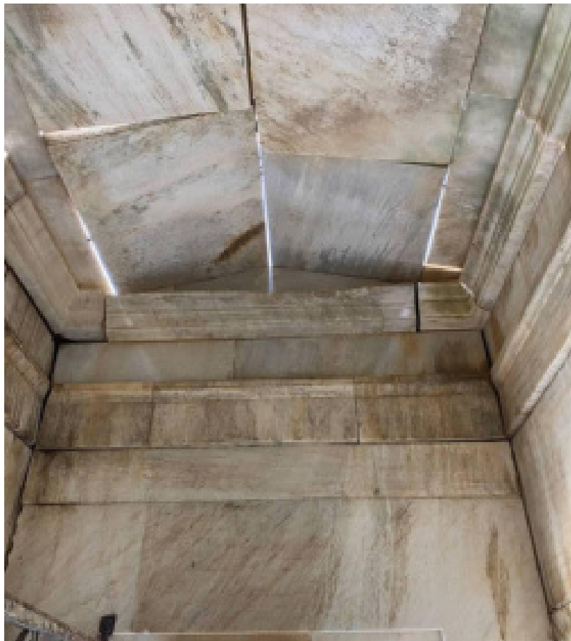
Φωτ. 20. Διανοίξη των αρμών στις λιθόπλακες της στέγης.
