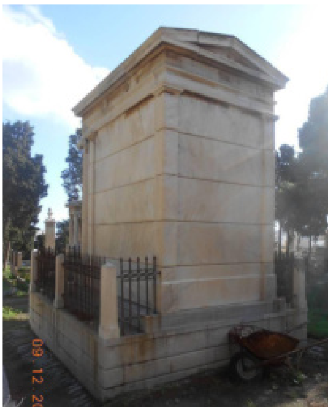
Φωτ. 13. Γενική άποψη του μνημείου από νοτιοανατολικά.
