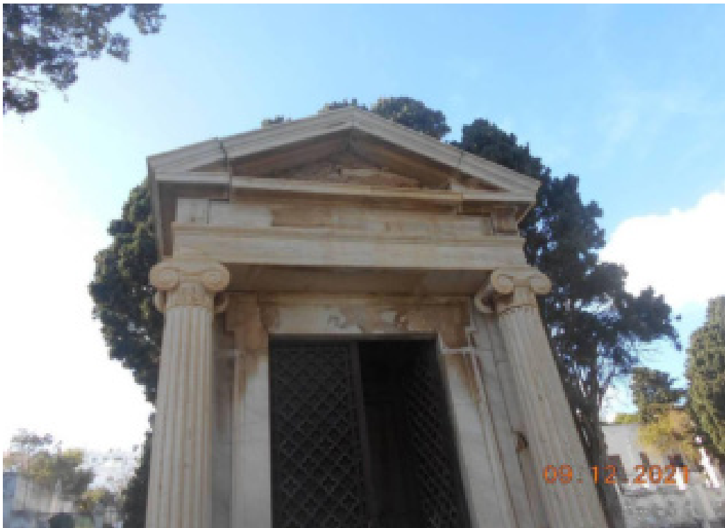
Φωτ. 9. Διάνοιξη των αρμών του διαζώματος στην ανατολική πλευρά του μνημείου.
