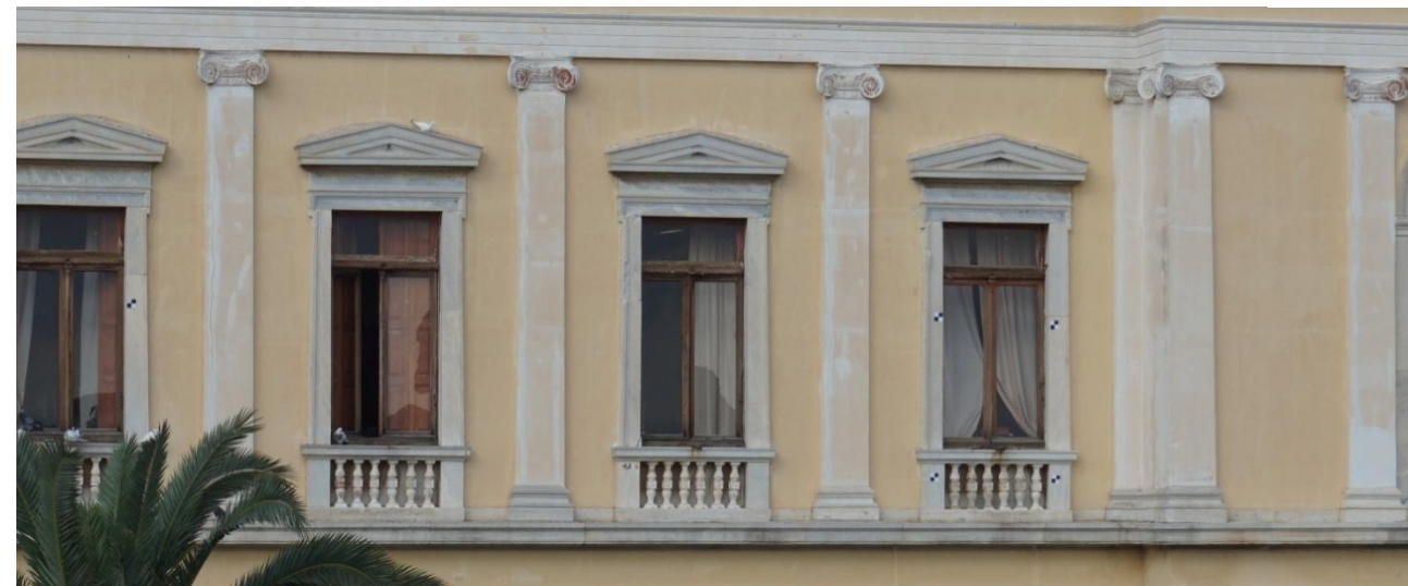
Εικ. 65 Έντονες χρωματικές αλλοιώσεις και ενίοτε ρωγμές εμφανίζονται κυρίως στις παραστάδες και στο σημείο σύνδεσης των μαρμάρινων πλαισίων ανοιγμάτων με την τοιχοποιία.
