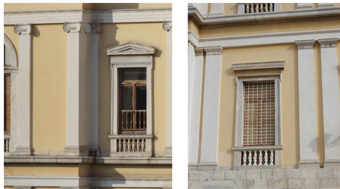
Εικ.165-166: Τα προς απομάκρυνση κιγκλιδώματα σε παράθυρα της νότιας και δυτικής όψης αντίστοιχα
