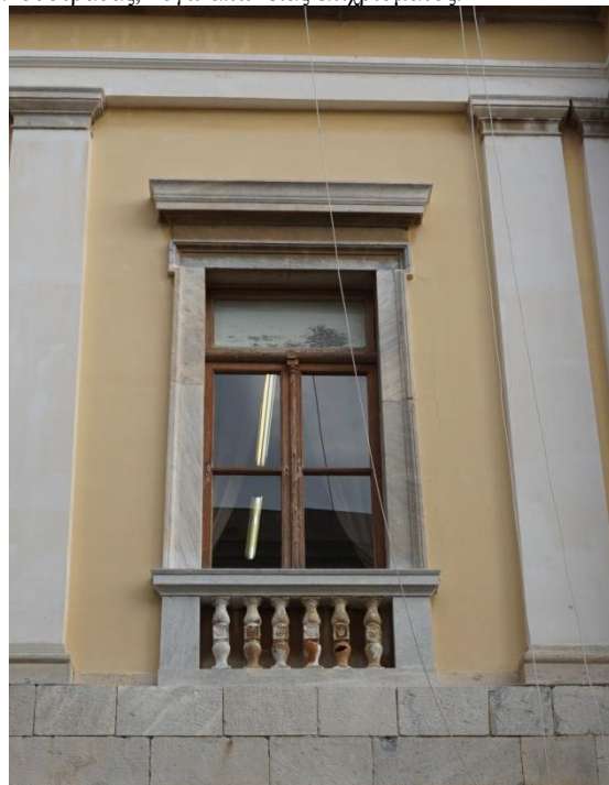
Εικ. 31- 32: Τυπική διαμόρφωση ανοίγματος και κουφώματος α' ορόφου. Δεξιά το αυθεντικό σχέδιο Ziller.
