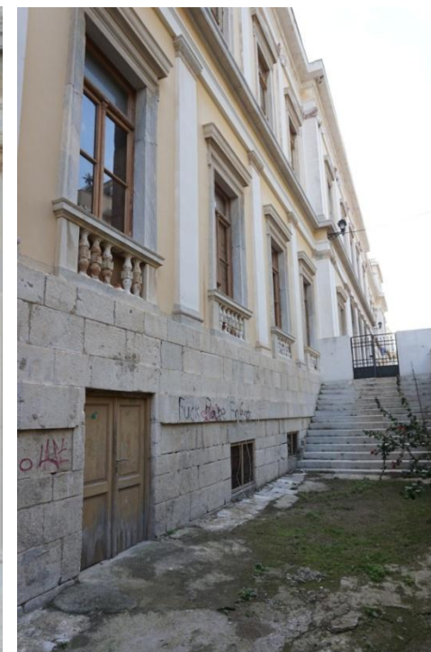
Εικ. 44: Τμήμα της βόρειας όψης με διαφορετικούς τύπους ανοιγμάτων στη βάση του κτιρίου
