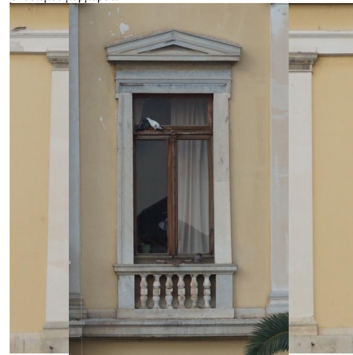
Εικ. 34: Τυπική διαμόρφωση ανοίγματος και κουφώματος β' ορόφου που ακολουθεί το αρχικό σχέδιο (βλ. εικ.20)
