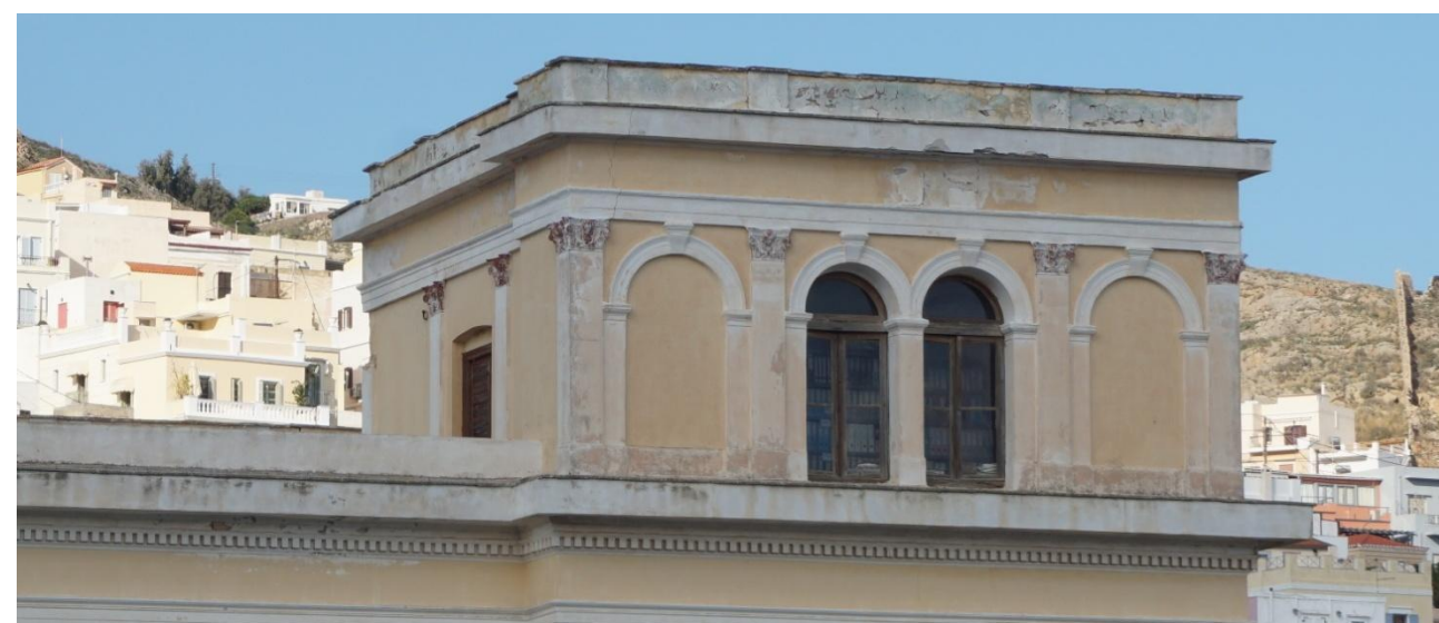
Εικ. 65 Έντονες χρωματικές αλλοιώσεις και ενίοτε ρωγμές εμφανίζονται κυρίως στις παραστάδες και στο σημείο σύνδεσης των μαρμάρινων πλαισίων ανοιγμάτων με την τοιχοποιία.
