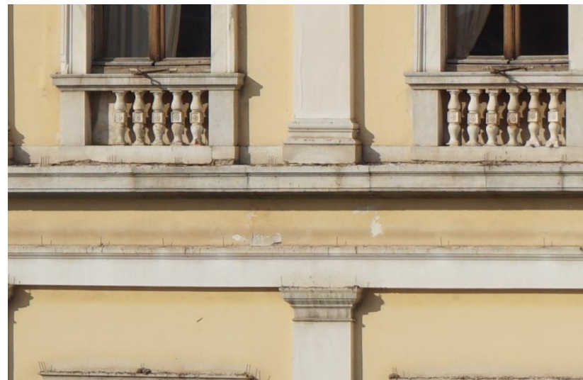
Εικ. 62, 63 Φαινόμενα αποκόλλησης του επιχρίσματος με αποκάλυψη και της λιθοδομής (στη νοτιοδυτική γωνία του κτιρίου) εμφανίζονται κυρίως κάτω από τα γείσα.
