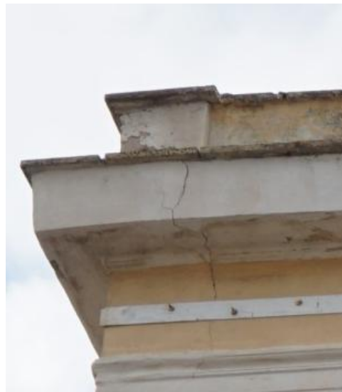
Εικ. 81, 82, 83: Βιογενείς κρούστες, αποκολλήσεις, θραύσεις στην επίστεψη των πύργων
