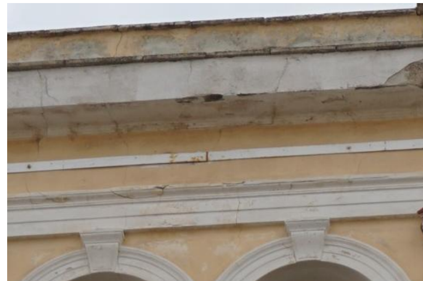
Εικ. 81, 82, 83: Βιογενείς κρούστες, αποκολλήσεις, θραύσεις στην επίστεψη των πύργων
