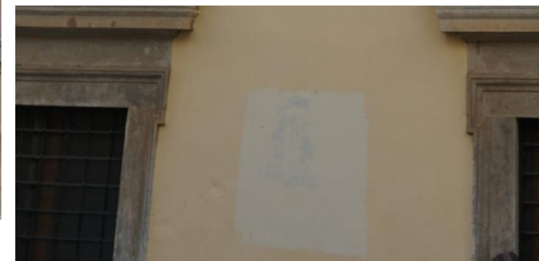
Εικ. 87,88: Χρωματικές αλλοιώσεις λόγω μεταγενέστερων επεμβάσεων
