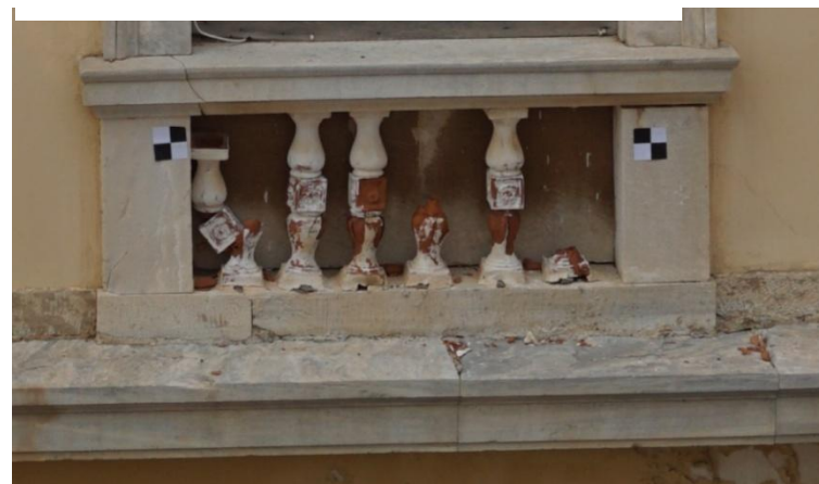
Εικ. 141: Φθορές - απώλειες μπαλουστρων
