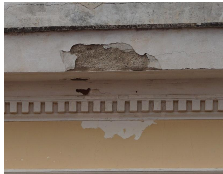
Εικ. 133: Οι σοβαρότερες φθορές εντοπίζονται στα γείσα και κάτω από αυτά
