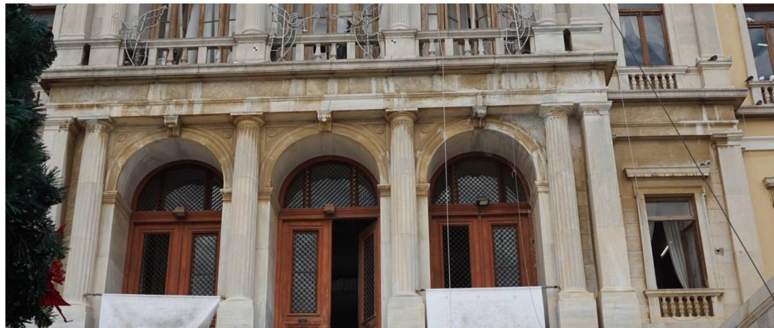
Εικ. 68, 69 Χρωματικές αλλοιώσεις λόγω επικάλυψης σοματιδίων και αέριων ρύπων στα μαρμάρινα στοιχεία του προπίλου.
