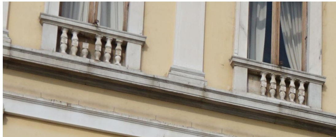
Εικ. 68, 69 Χρωματικές αλλοιώσεις λόγω επικάλυψης σοματιδίων και αέριων ρύπων στα μαρμάρινα στοιχεία του προπίλου.
