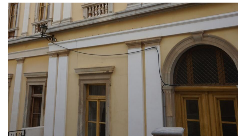
Εικ. 61 Ανάρτηση δικτύων στη βόρεια όψη
