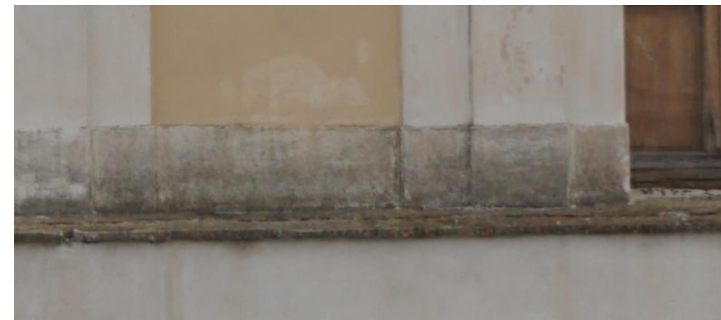
Εικ. 84: Βιογενείς κρούστες στη βάση των τραβηγτών διακοσμητικών στοιχείων στη ανώτερη στάθμη των πύργων.
