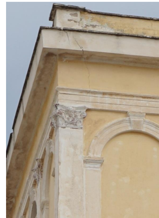
Εικ. 111: Η επίστεψη των πύργων παρουσιάζει τις μεγαλύτερες φθορές
