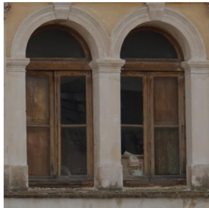
Εικ. 100 έως 106: φθορές, απώλεια των χρωματισμών στα κουφώματα , σημάδια σήψης
