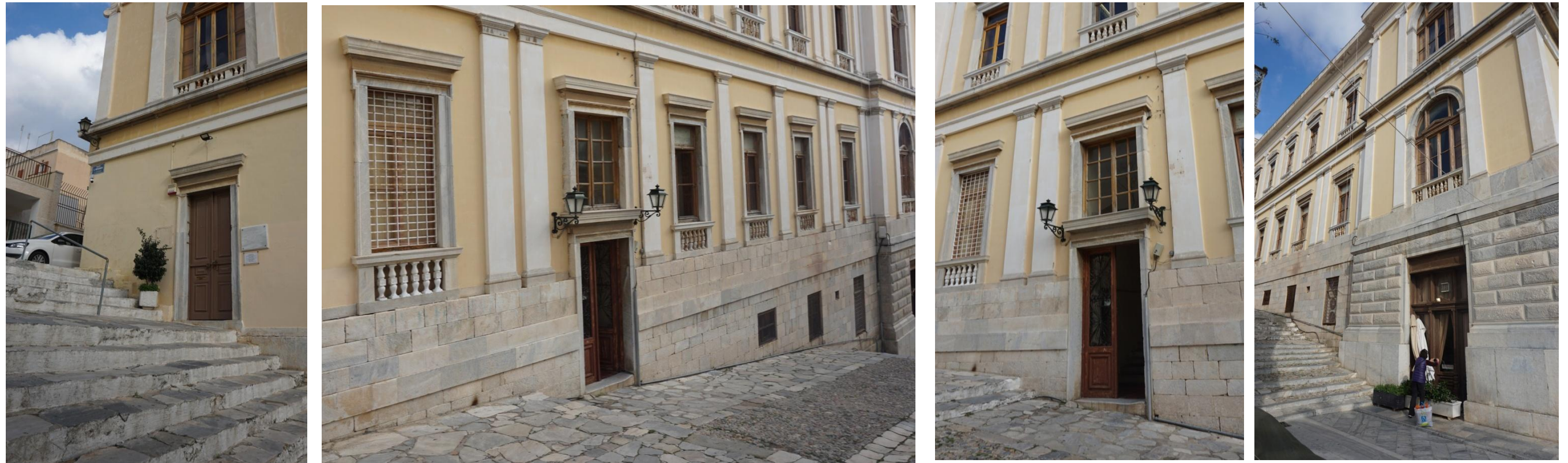
Εικ. 48 έως 51: Διαμορφώσεις διαφορετικών τύπων ανοιγμάτων - κουφωμάτων λόγω αναγλύφου στη Δυτική όψη. Διακρίνεται η ψευδοϊσόδομη τοιχοποιία στη βάση του κτιρίου και οι σφυρήλατες σιδεριές στην κεντρική θύρα εισόδου
