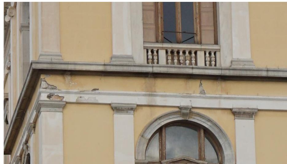
Εικ. 62, 63 Φαινόμενα αποκόλλησης του επιχρίσματος με αποκάλυψη και της λιθοδομής (στη νοτιοδυτική γωνία του κτιρίου) εμφανίζονται κυρίως κάτω από τα γείσα.
