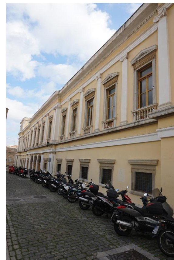
Εικ. 26, 27: Βόρεια όψη
