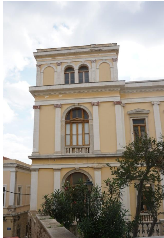
Εικ. 29- 30: Οι παραστάδες διαφορετικού ρυθμού ανά όροφο. Εμφανές είναι το υλικό κατασκευής των επίκρανων και της μπαλουστράδας, λόγω απώλειας επιγρίσματος.
