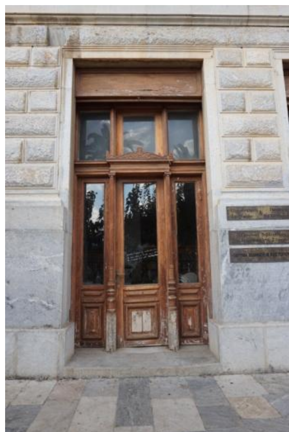
Εικ. 41: Ισόδομο σύστημα τοιχοποιίας και τυπικό κούφωμα καταστήματος ισογείου. Το κούφωμα αποτελείται από τρία κατακόρυφα στοιχεία από τα οποία το μεσαίο είναι κινητό. Οριζόντια χωρίζεται σε τρεις ζώνες: Στο βασικό άνοιγμα, στους φεγγίτες και στο κουτί του ρολού. Το κούφωμα διακοσμείται από σύνθετους κιονίσκους με ιωνικά κιονόκρανα που φέρουν οριζόντιο θρηγικό με απόληξη μοφής αετώματος πλούσια διακοσμημένης.
