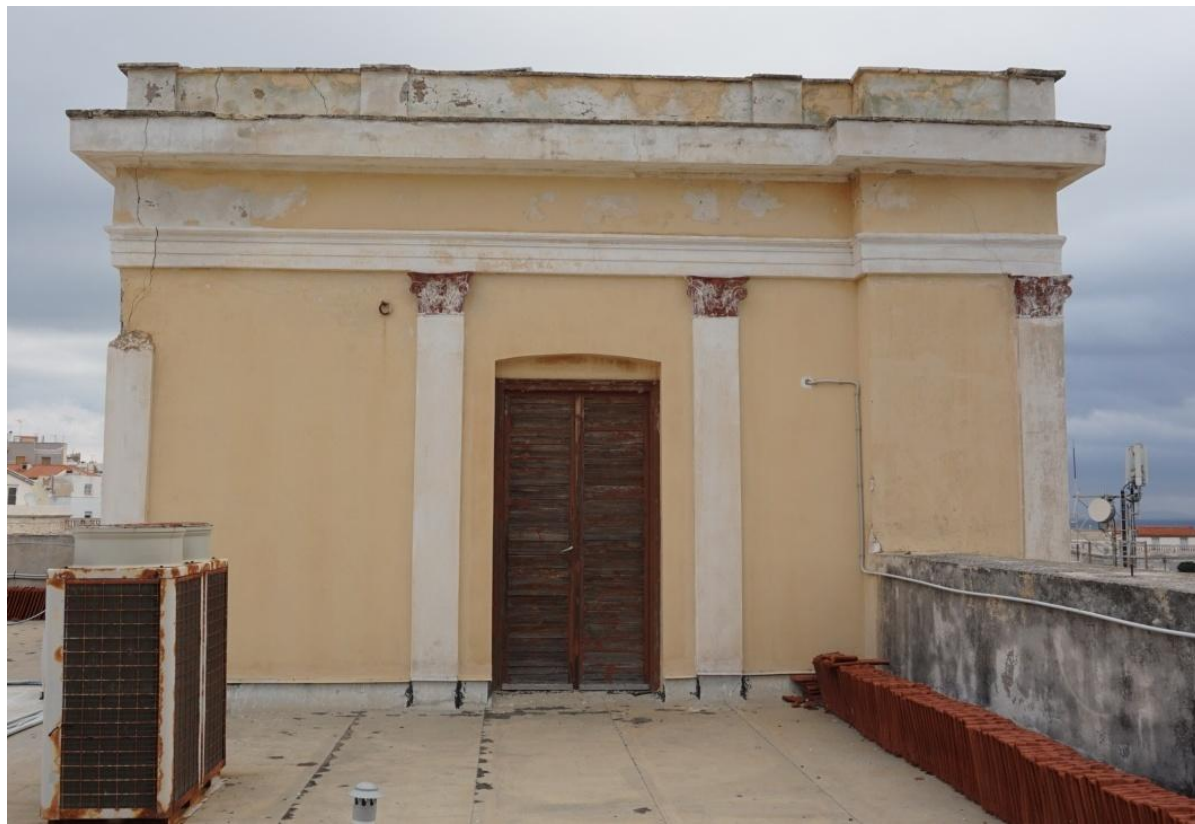
Εικ. 157 - 158: Εσωτερικές όψεις νοτιοανατολικού πύργου. Στις γωνίες αριστερά και δεξιά απουσιάζουν πλήρως τα επίκρανα. - Αποσαθρώσεις επιχρισμάτων παρουσιάζονται εκτεταμένες στο στηθαίο, το γείσο και κάτω από το γείσο.
