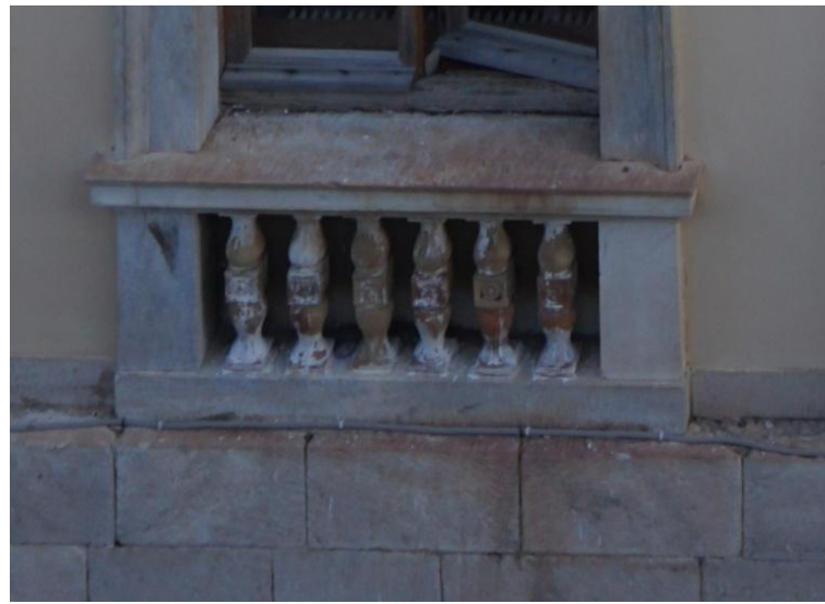
Εικ. 119-120: Απώλεια χρωματισμών στα κεραμικά στοιχεία
