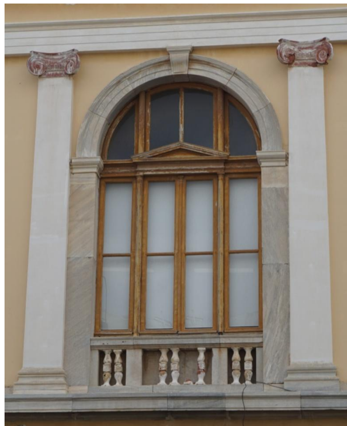
Εικ. 42: Τυπικό κούφωμα πύργου β' ορόφου. Τα διακοσμητικά στοιχεία που περιβάλλουν το άνοιγμα είναι μαρμάρινα, πλην των κολωνακίων μπαλουστρών που είναι κεραμικά. Οι παραστάδες και η άνω διαχωριστική ταινία είναι από τραβηχτό κονίαμα. Διακρίνονται το υλικό κατασκευής των επίκρανων των παραστάδων λόγω της απώλειας επιχρίσματος.
