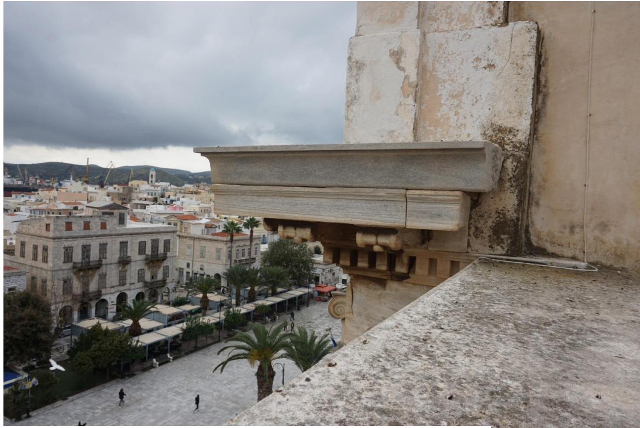
Εικ. 36-37: Το μαρμάρινο οριζόντιο γείσο επίστεψης του Προπύλου
