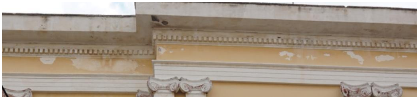
Εικ. 80: Φαινόμενα αποκόλλησης του επιχρίσματος κάτω από τα γείσα.
