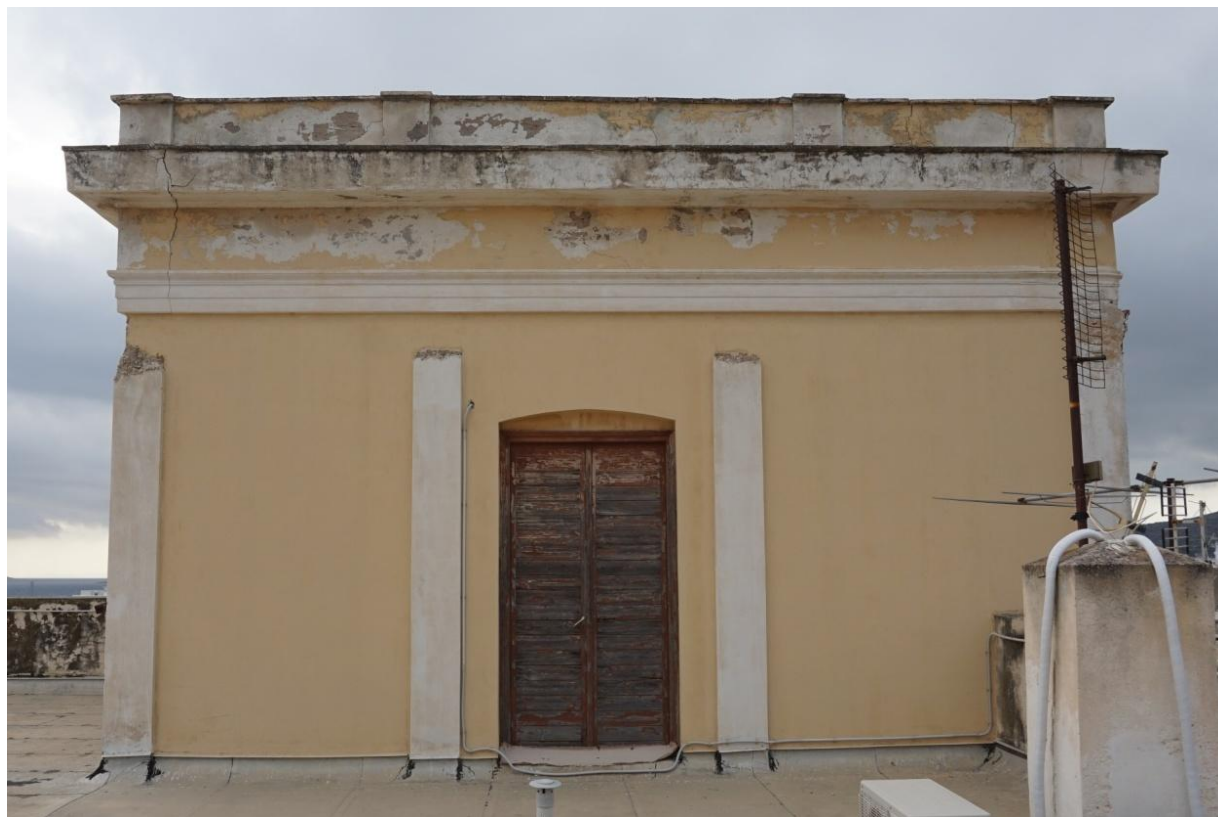
Εικ. 159 - 160: Εσωτερικές όψεις νοτιοδυτικού πύργου. Στη μία πλευρά και στη γωνία δεξιά απουσιάζουν πλήρως τα επίκρανα. - Αποσαθρώσεις επιχρισμάτων παρουσιάζονται εκτεταμένες στο στηθαίο, το γείσο και κάτω από το γείσο.
