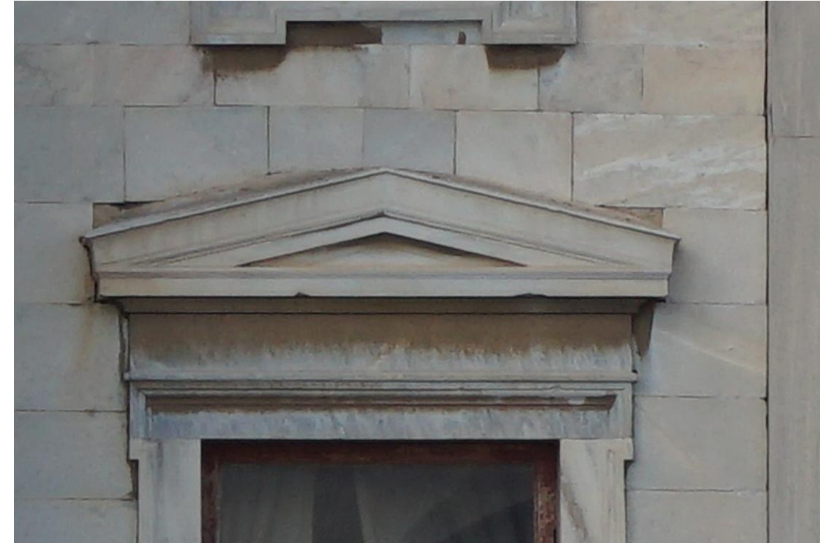
Εικ. 70 Επικαθήσεις και σπασίματα σε μαρμάρινα στοιχεία του προπίλου
