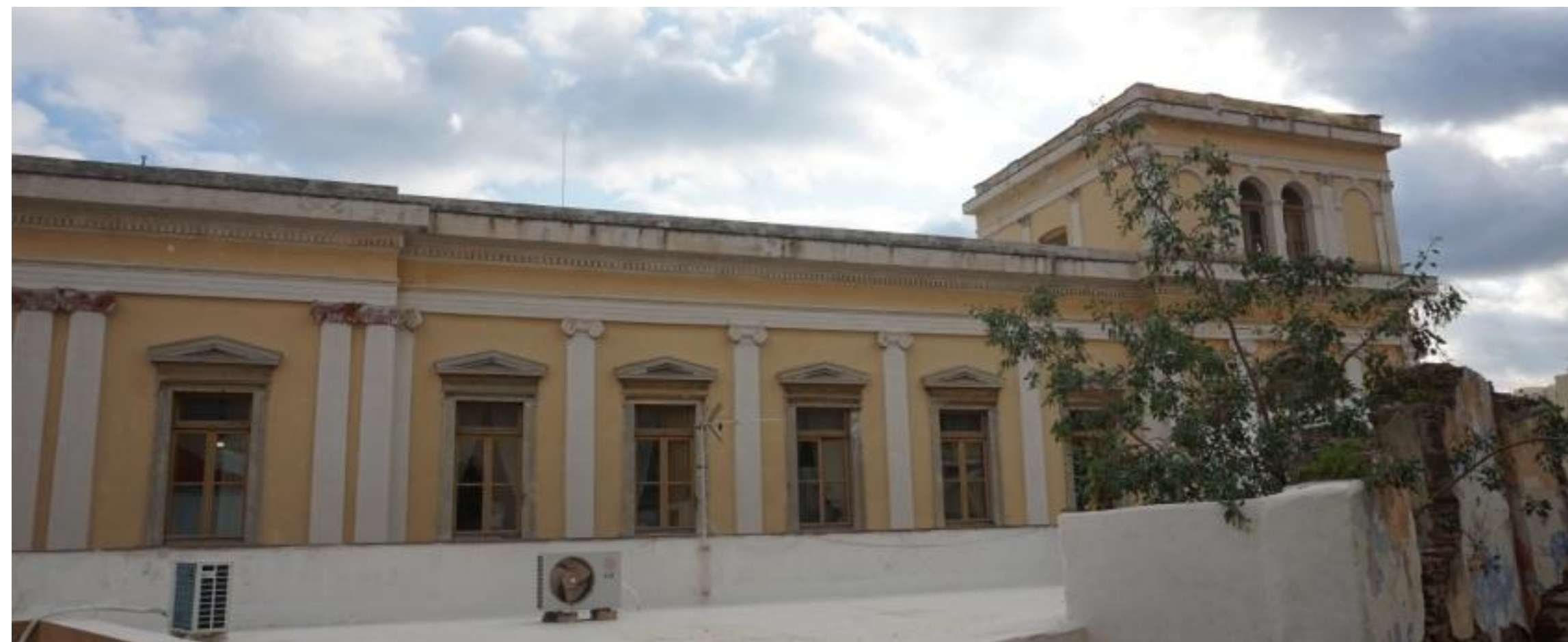
Εικ. 87,88: Χρωματικές αλλοιώσεις λόγω μεταγενέστερων επεμβάσεων
