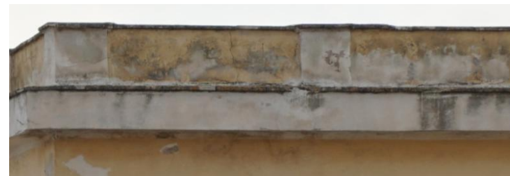
Εικ. 84: Βιογενείς κρούστες στη βάση των τραβηγτών διακοσμητικών στοιχείων στη ανώτερη στάθμη των πύργων.
