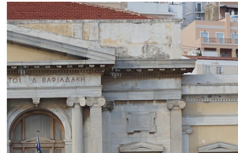
Εικ. 64 Εμφάνιση βιογενούς κρούστας και αποκολλήσεις επιχρισμάτων στο κεντρικό τμήμα .
