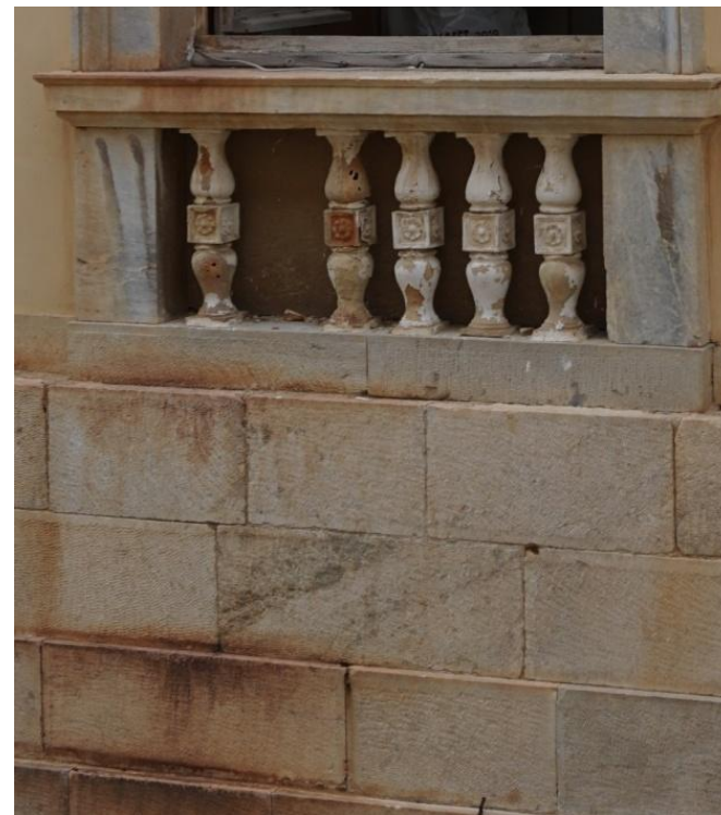
Εικ. 144: Επικαθήσεις στα μάρμαρα και φθορές μπαλουστρων
