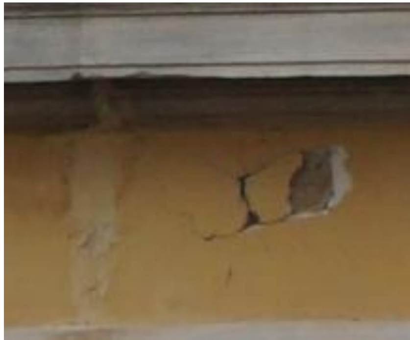
Εικ. 77 έως 78: Φαινόμενα αποκόλλησης του επιχρίσματος εμφανίζονται κυρίως κάτω από τα γείσα.
