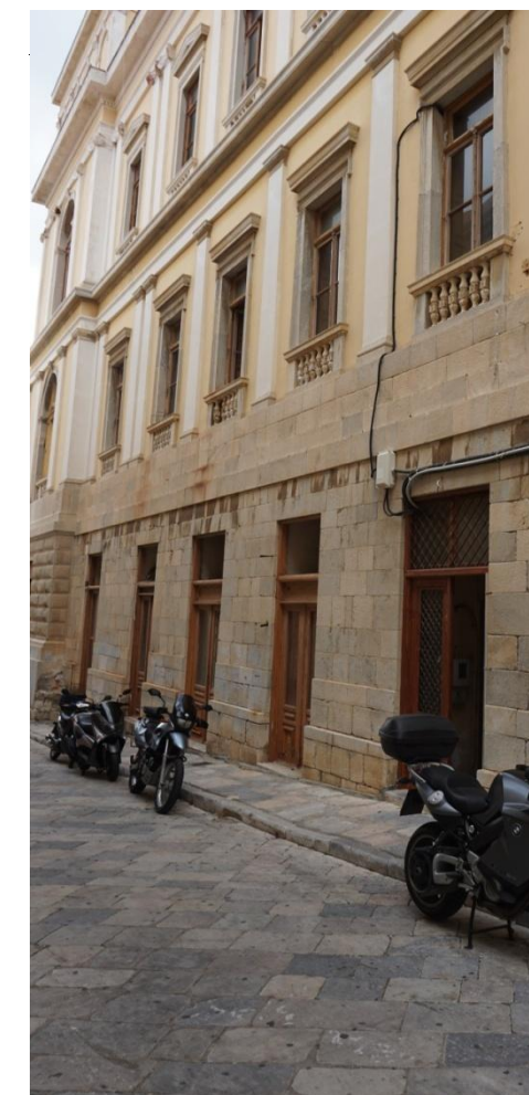
Εικ. 47: Οι θύρες ισογείου επί της ανατολικής όψης διατηρούν ενιαίο πρέκι και διαφοροποιούνται καθ' ύψος λόγω του αναγλύφου.
