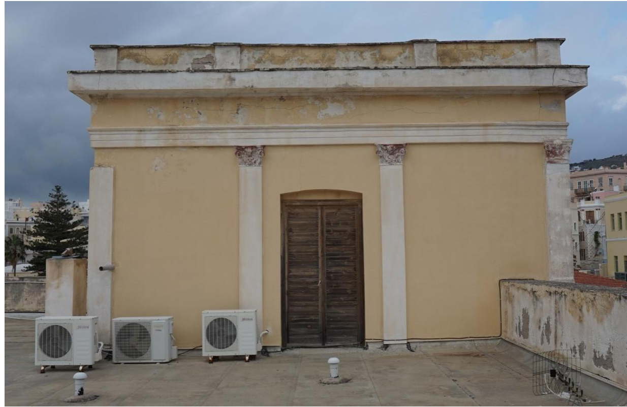
Εικ. 161 - 162: Εσωτερικές όψεις βορειοδυτικού πύργου. Στις γωνίες αριστερά και δεξιά απουσιάζουν πλήρως τα επίκρανα.. - Αποσαθρώσεις επιχρισμάτων παρουσιάζονται εκτεταμένες στο στηθαίο , το γείσο και κάτω από το γείσο.
