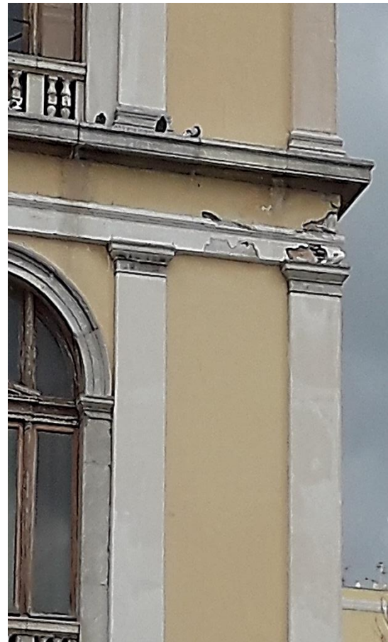
Εικ.2, Νότια όψη τραβηχτά διακοσμητικά στοιχεία, Εικ.3 Απώλεια κονιάματος
