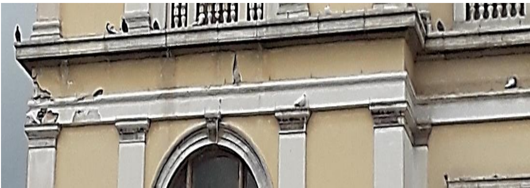
Εικ.13 Απώλειες κονιάματος- Αποκολλήσεις- Βιολογική προσβολή
