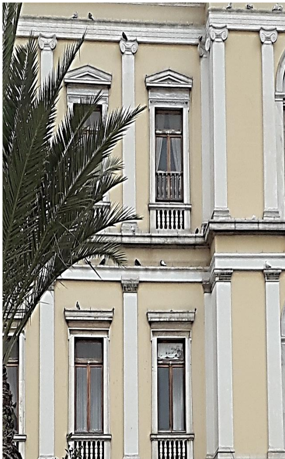
Εικ.2, Νότια όψη τραβηχτά διακοσμητικά στοιχεία, Εικ.3 Απώλεια κονιάματος
