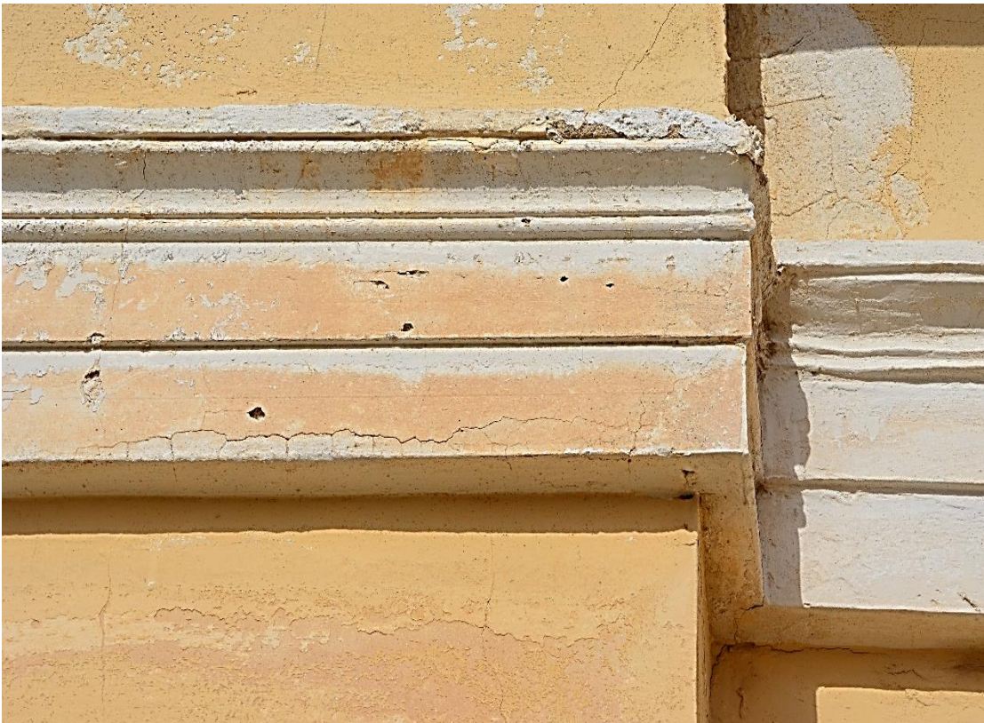
Εικ.6 Απώλεια κονιαμάτων- Απολεπίσεις χρωματικού στρώματος
