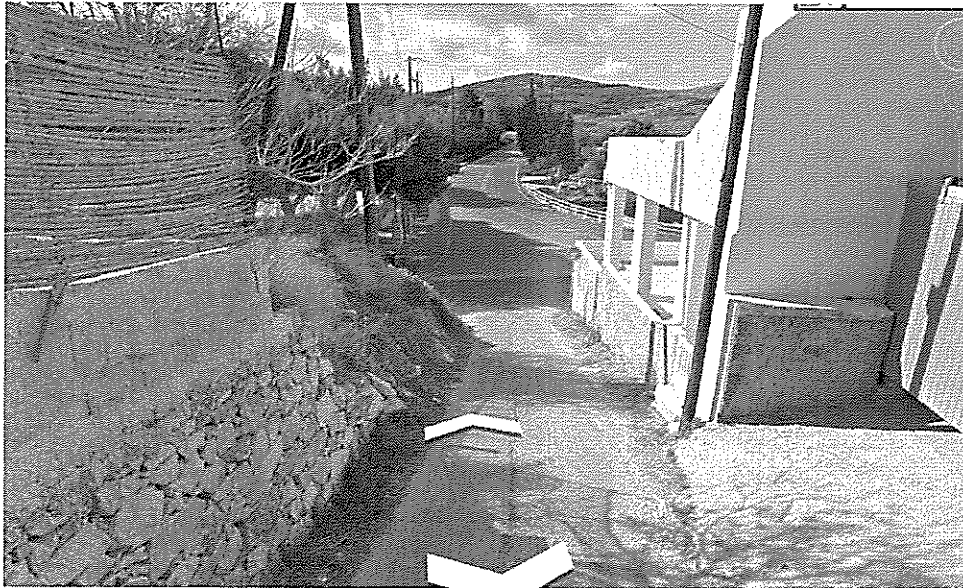
Εικόνα 4: Φωτογραφία από το google earth, επί δημοτικής οδού που προτείνεται προς μονοδρόμηση, με κατεύθυνση από Αζόλιμνο προς τον ισόπεδο κόμβο -συμβολή με την επαρχιακή οδό, όπου φαίνεται η δυσκολία ορατότητας τόσο από την αριστερή όσο και από τη δεξιά πλευρά.
